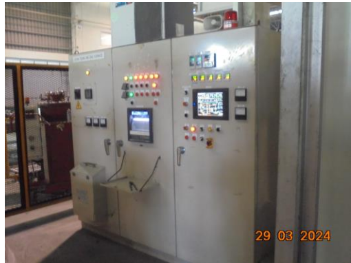
รูปที่ 3 ระบบ Inter Lock
