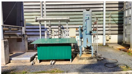
รูปที่ 14 ระบบผลิตน้ำอ่อน (Back Wash)
