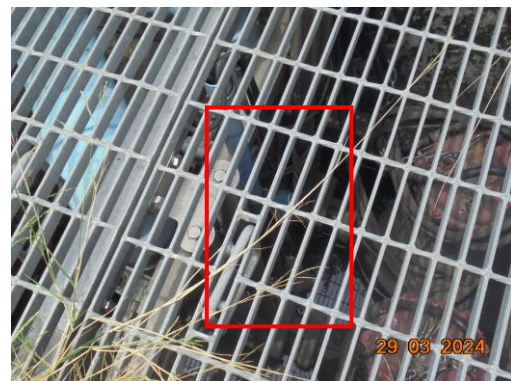
รูปที่ 20 ลูกกลอยควบคุมการเดินเครื่องสูบน้ำ
